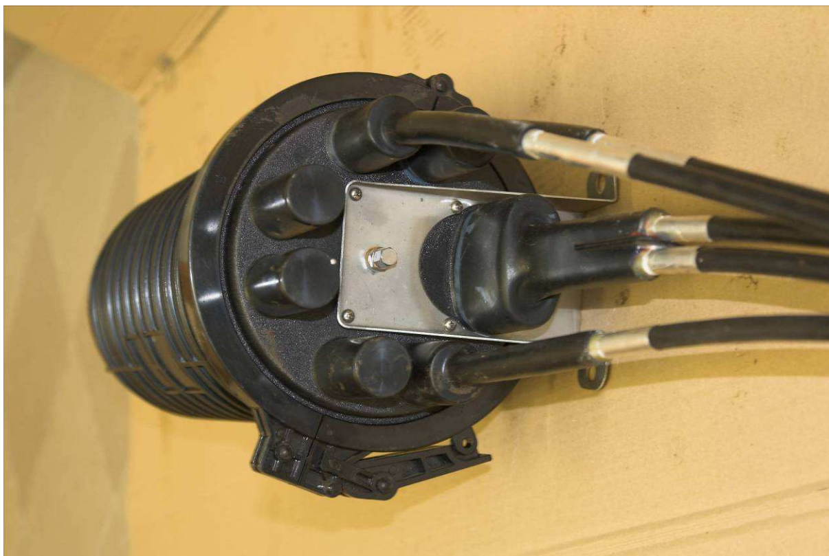
Rys.4. Widok mufy DJS-714 z przepustami kablowymi.
